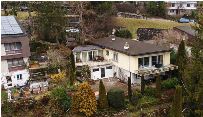
Abbildung 2: Foto Bestand Stuckishausstrasse 15
