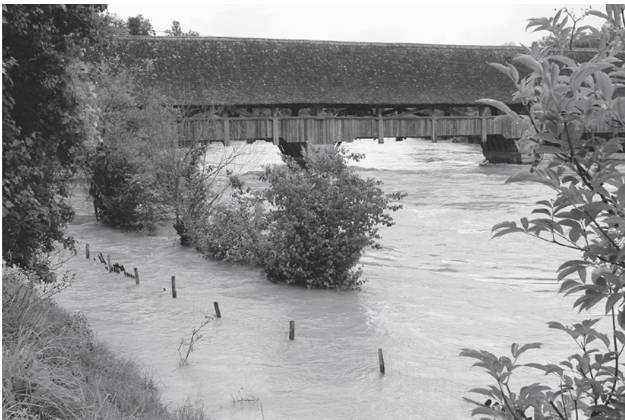
Hochwasser bei der Neubrücke
