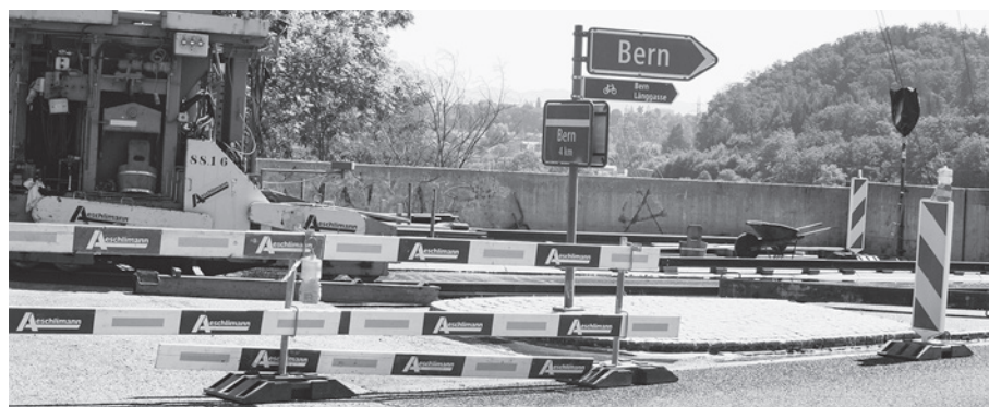
Baustelle auf der Halenbrücke
