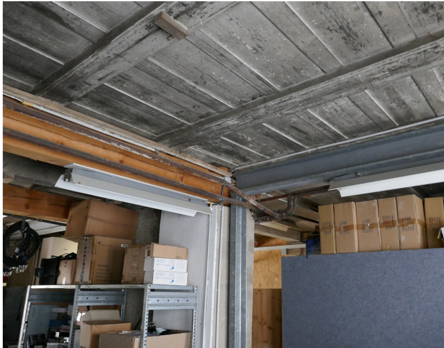
Decke über dem Erdgeschoss des Anbaus mit zahlreichen Verstärkungen der Statik
