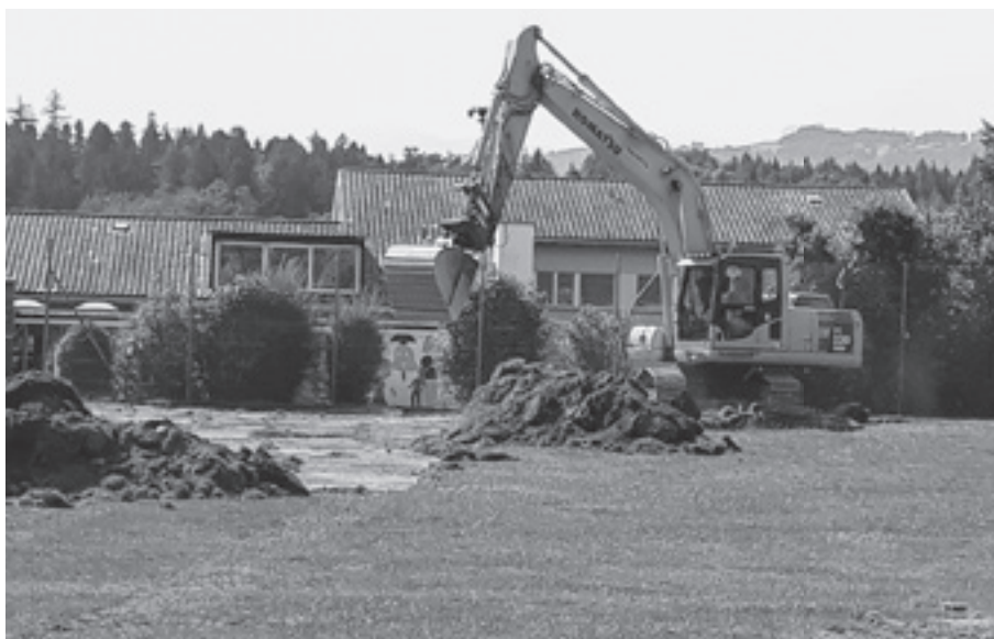
Start der Bauarbeiten am Schulhaus Herrenschwanden
