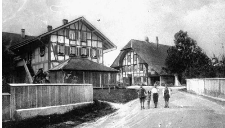
Blick von Südosten auf die Ostfassade des damaligen Käsereigebäudes, heute Gemeindehaus (links).
